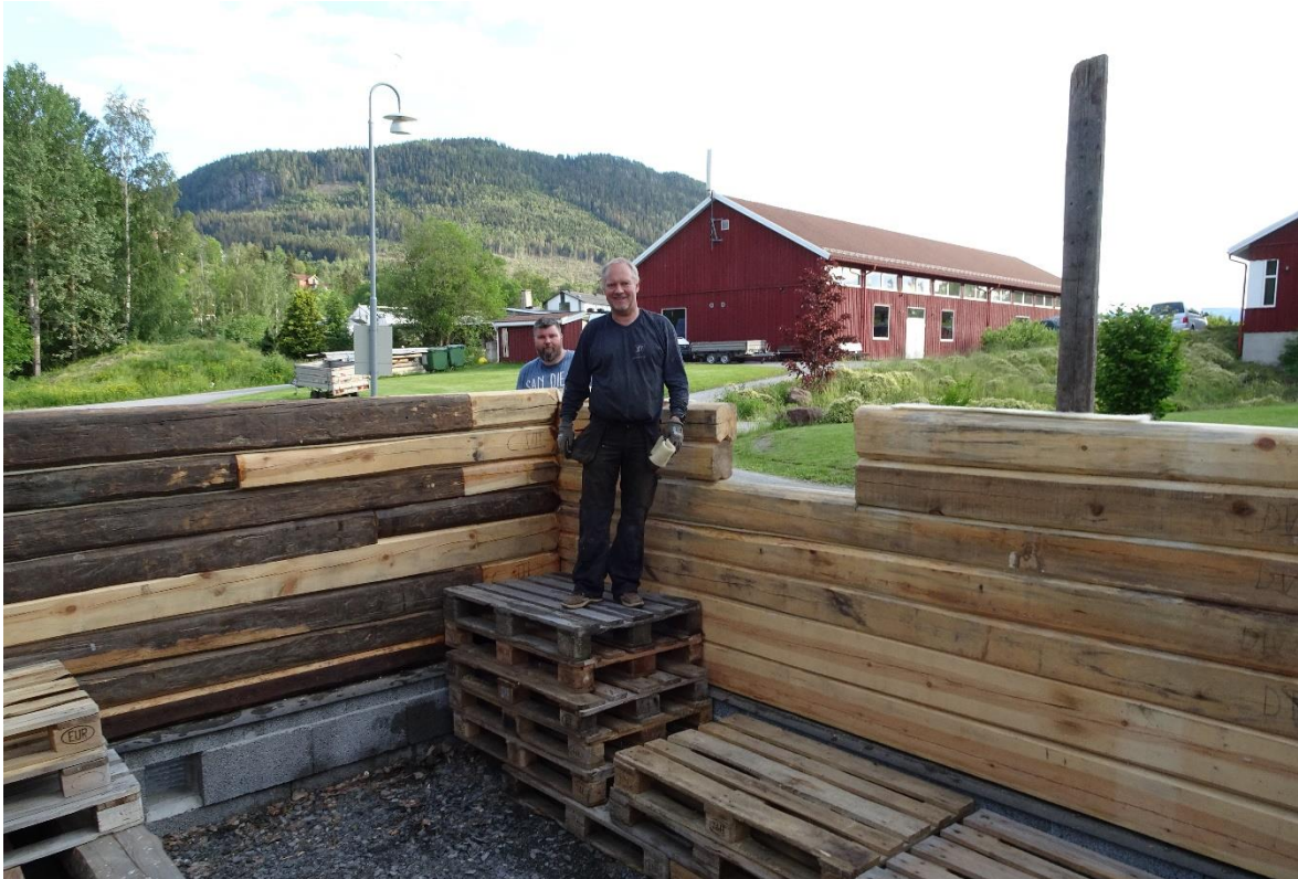
Rolf Dybdal til v. og Morten Molteberg under oppføringen av tømmerveggene. Juni 2019. De har gjort en kjempeinnsats for å få opp småkårshuset.
