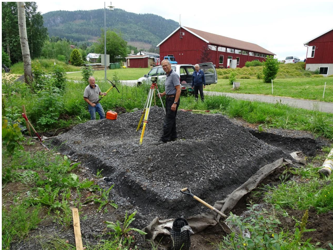
Per Dæhli i ferd med å måle opp for grunnmuren. Erik Moe Haugen med hakke. Juni 2018.
