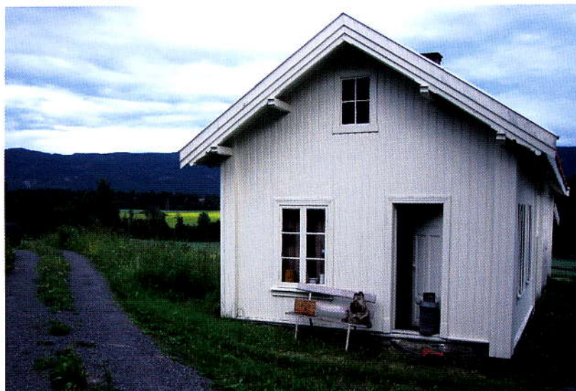
Landhandelen i Østigarden holdt til i dette huset fra ca. 1890 til rundt 1910. Som vi ser lå landhandelen den gang sentralt til med veien til Åsa rett i butikkdøra. Tekst og bilde: Helge Bihli, Østigarden Hårum, 2007.
